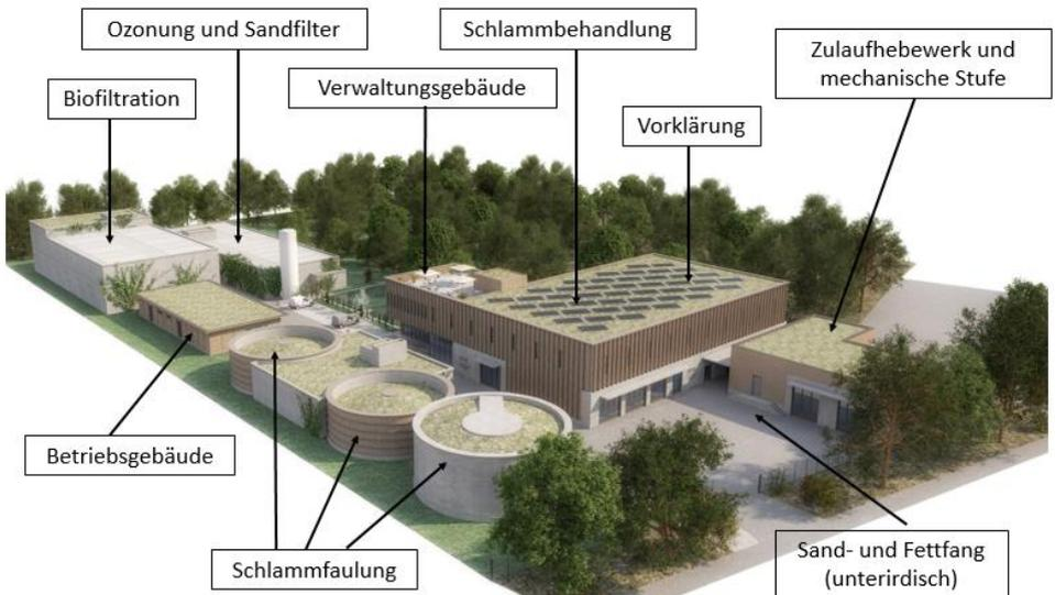
Abbildung 2: Die neue ARA Seeland Süd und ihre Verfahrensstufen / Anlagenobjekte (Visualisierung: Rykart Architekten AG)
